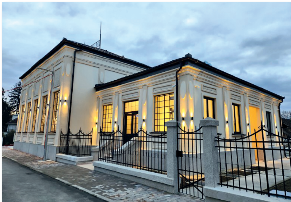
https://mipcro.hr/referentna-lista/gradska-munjara-petrinja-110/ , preuzeto 2. 8. 2024. Fotografija novoobnovljene zgrade električne centrale u Petrinji.
