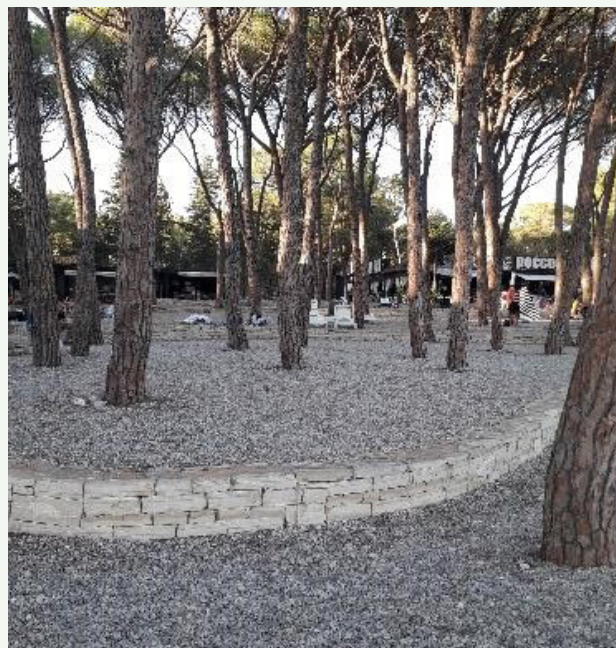
Slika 12. Promjena razine tla navoženjem kamenog materijala.
